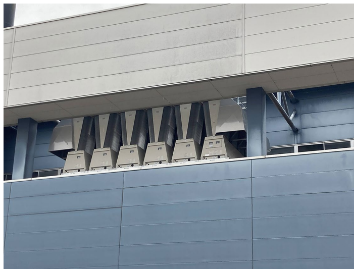
更新された電気式モジュールチラー
