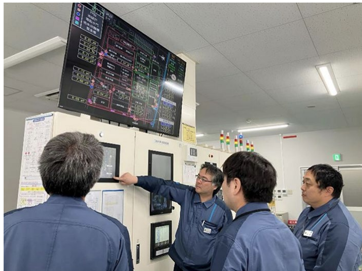
黒部製造所 油水分離槽の異常対応訓練
