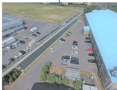
四国製造所 50kW（2019年度） 50kW（2022年度）
