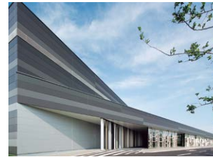
2011年に操業を開始した 埼玉窓工場
