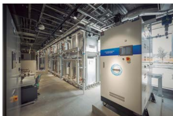
水素を製造、貯蔵するP2Gシステムの設備
