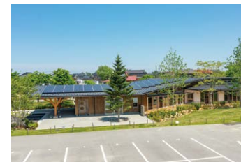
第4街区：省エネ性能と創エネでZEBを達成
