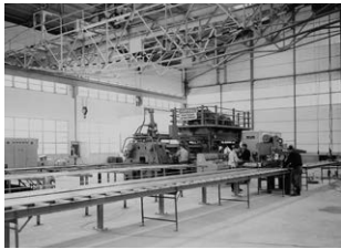
1959年に設置した アルミ押出機
