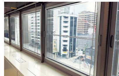
大阪市「谷町YFビル」執務エリアにBIPV内窓を設置。2025年10月から約1年をめどに、実用化・事業化に向けた実装検証を行っている
