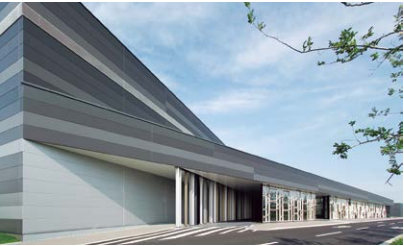
2011年に操業を開始した埼玉窓工場
