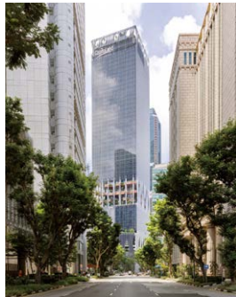
施工例：CapitaSpring ビルの外周を緑化することで、環境改善や景観向上に貢献します。 Photo: CapitaLand
