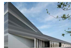
2011年に操業を開始した埼玉窓工場
