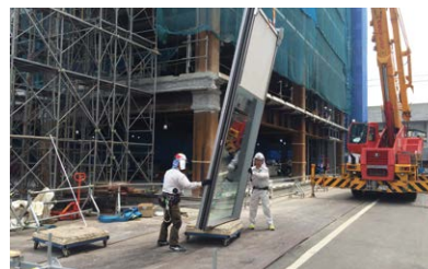
ユニタイズドCWの施工の様子
