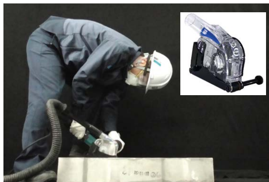
「ダイヤモンドカッター用 集塵カバー」(右上)を活用した施工風景
