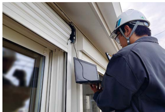
デジタルツールを使用した電装商品のメンテナンス
