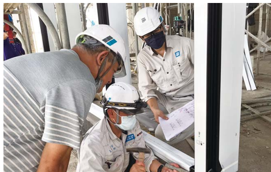
台湾での現場施工研修
