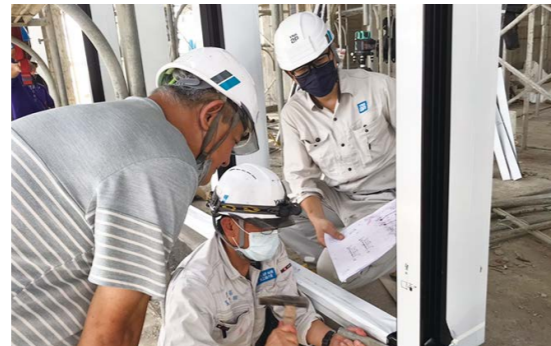
台湾での現場施工研修
