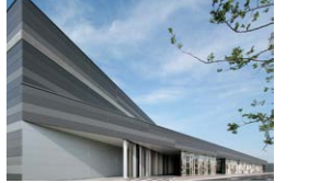
2011年に操業を開始した埼玉窓工場
