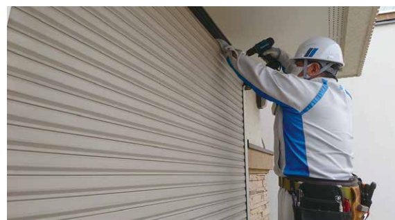
YKK APメンテナンス認定技能士によるシャッターのメンテナンス
