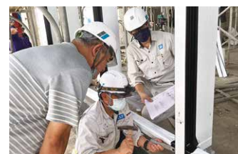
台湾での現場施工研修
