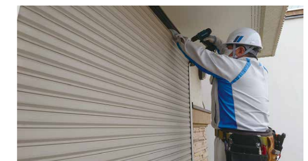
YKK APメンテナンス認定技能士によるシャッターのメンテナンス
