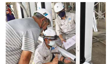
台湾での現場施工研修
