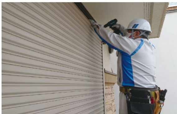
YKK APメンテナンス認定技能士によるシャッターのメンテナンス
