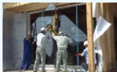
足場用吊り上げ治具
