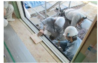
「APW」施工研修
