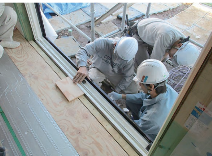
APW施工研修
