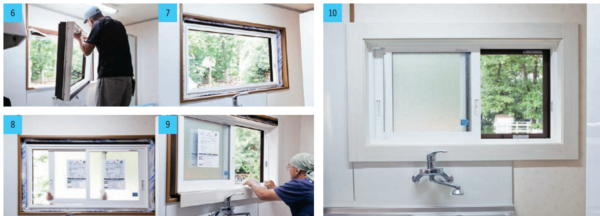
「かんたんマドリモ」リフォーム施工の流れ
