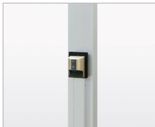
外部コンセント(200V用)
