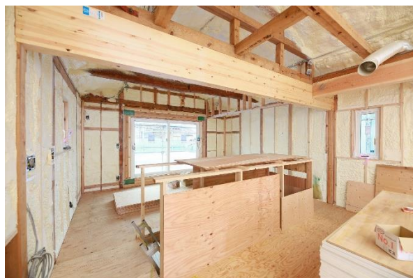
「FRAME II」(BOX型)設置箇所の様子
