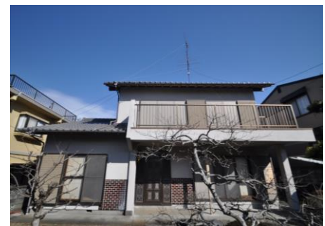
左: AFTER 外観 右: BEFORE 外観
