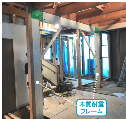
改修中の「FRAME II」設置箇所
