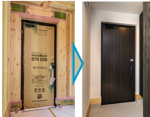
玄関部に使用された「FRAME II」 左：施工中 と 右：After
