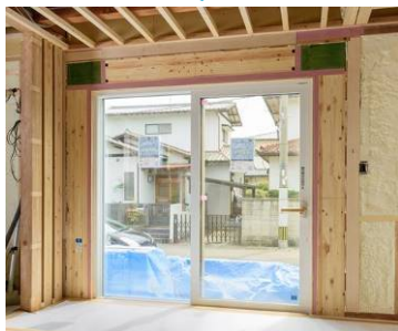
左上：Before、左下：施工中（樹脂窓と開口部耐震商品）、右：After
