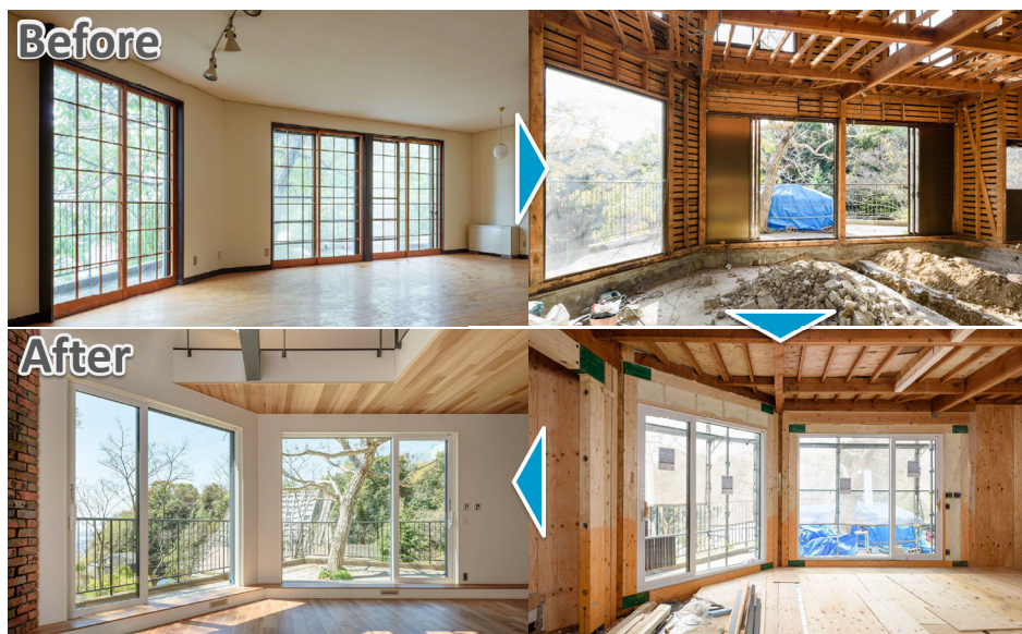
「フレーム II」設置箇所の Before⇒解体時⇒施工中 ⇒After の様子
