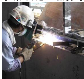
[一般的な施工（溶接）]
