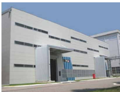
高効率押出機へ更新した 黒部製造所 押出ライン棟
