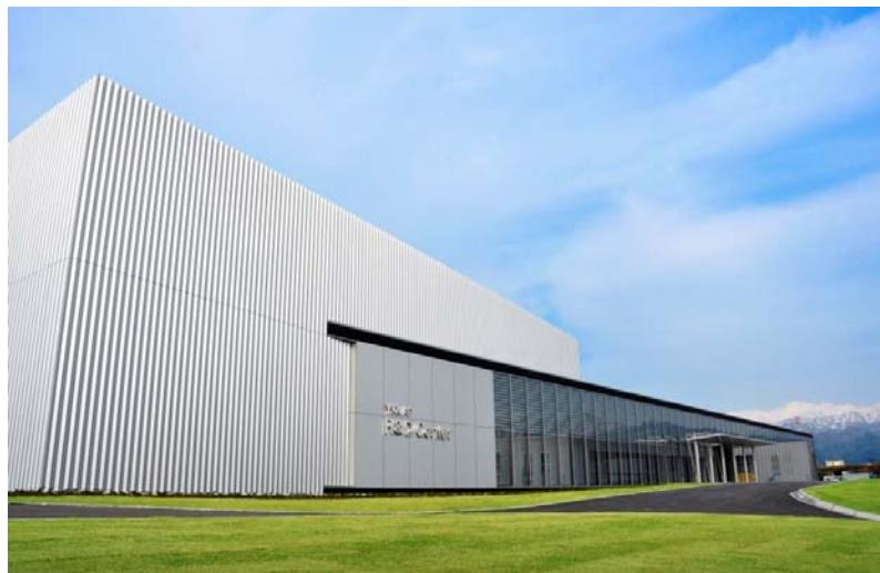
「YKK AP R&Dセンター」の建物は、技術の総本山のシンボルとして、アルミのシルバーとクリアなファサードが特徴です。外装は、温熱環境に配慮したダブルスキンカーテンウォールシステムで、ダブルスキンの内側には樹脂窓「APW330」の引違い窓を採用し断熱性能を向上させています。またオフィス空間のハイサイドライト部には、自然換気窓「バランスウェイ」を採用し、効率的な自然換気システムと自然光を取り込むといった、環境に配慮した商品が使われています。これらの効果により、通常のオフィスの約50%の一次エネルギー削減を見込んでいます。
