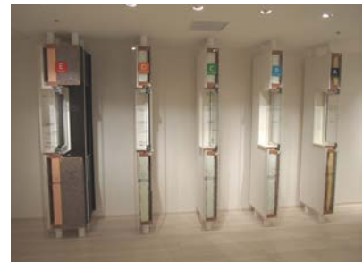
5つの部屋の断熱構造
